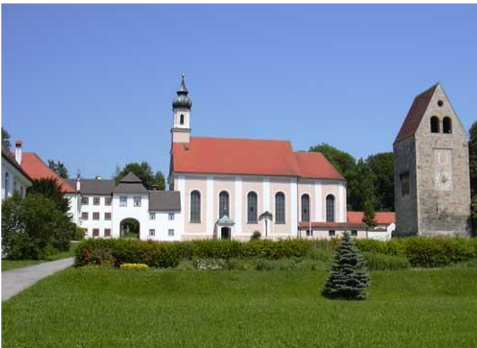
Pfarrkirche St. Johannes Baptist mit dem mittelalterlichen Wehrturm "Grauer Herzog"
