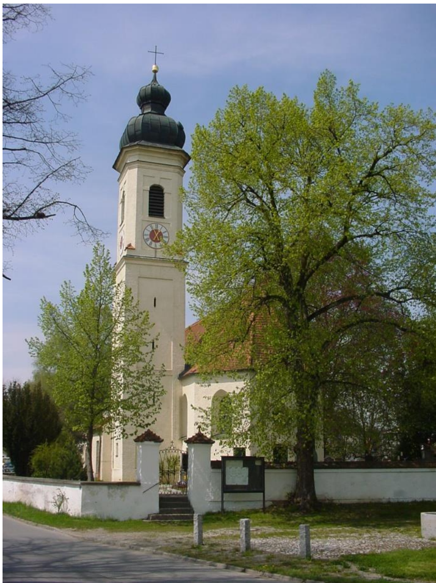
Kirchturm der Pfarrkirche Hörbach von Osten. Foto: T. Drexler
